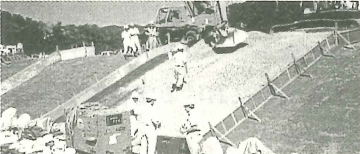
写真-1 ポラスコンクリートの打設状況
