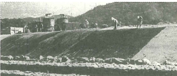
写真-2 保水材・肥料の充填状況
