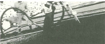
写真-3 薄層客土の吹付け状況
